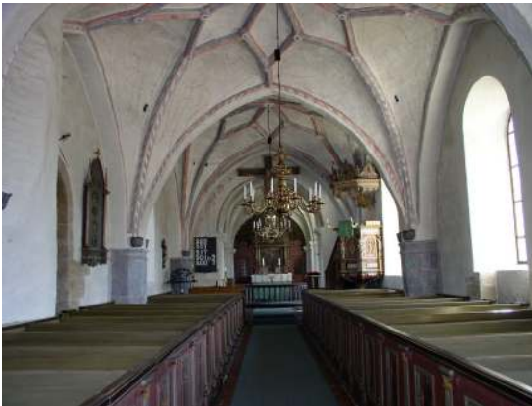
Bild 1: Kyrkorummet sett mot öster.
