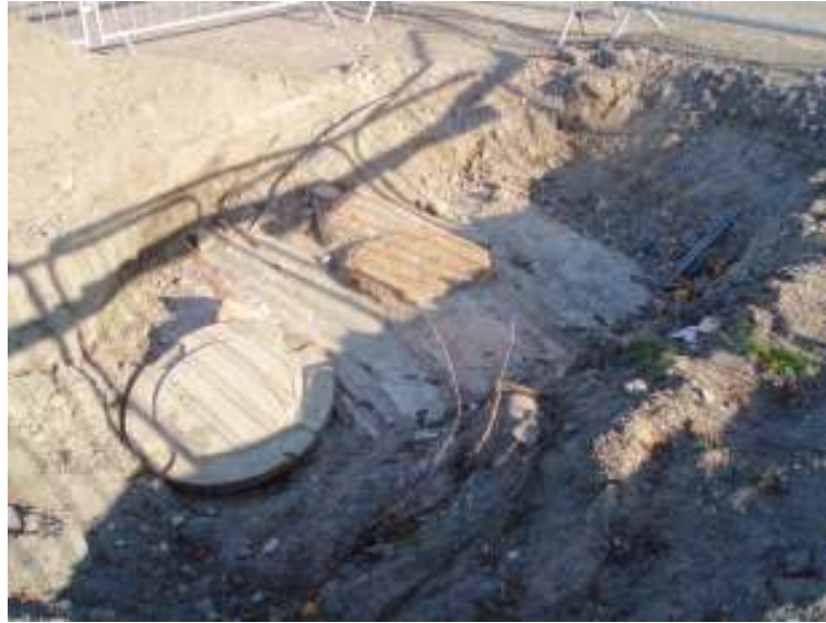
Fig. 4. Valv som täckte brunnen. Däxel i mellersta valvet. Betonglocket täcker det hål i valvet som utbstod vid schaktningen.
