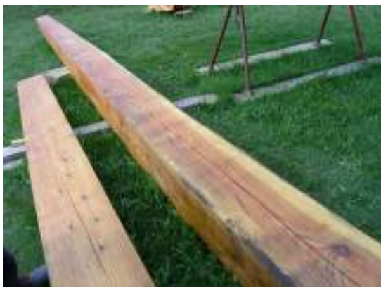
Nyttillverkad vingbalk och tillhörande baksadling.
