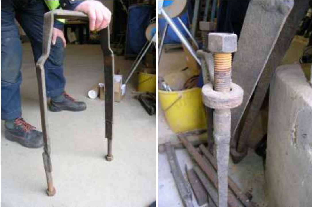
Entreprenören håller upp en äldre klammer.
