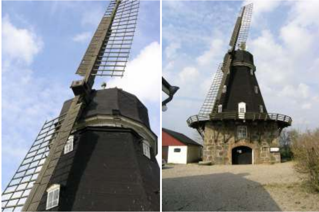
Övraby mölla i samband med det första byggmötet tillsammans med den antikvariska kontrollanten.
