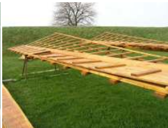
Vingar med stormluckor på tork efter att strykning med linolja, träjära och balsamterpentin.
