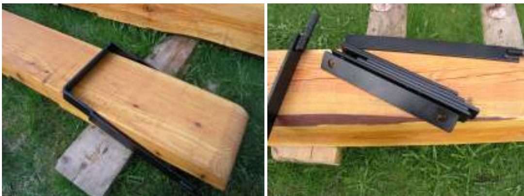
Nyttillverkade klamrar innan de åtgärdades och fick en kulturhistoriskt mer anpassad ytbehandling, i form av blästring och därefter målning med svart, äkta linoljafärg.
