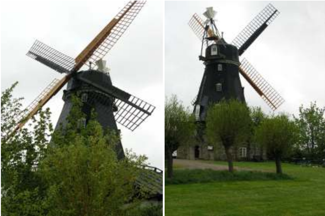
Övraby mölla efter att de nya vingarna har monterats.
