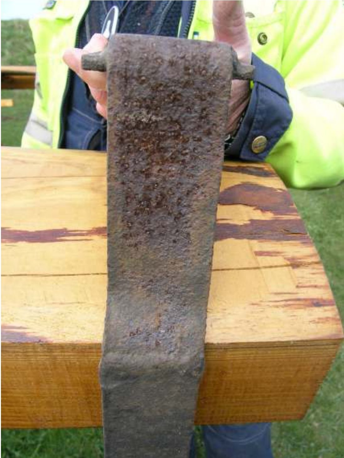
En av de äldre klamrarna provas på vingbalken, för att ta reda på hur avpassningen kan lösas.
