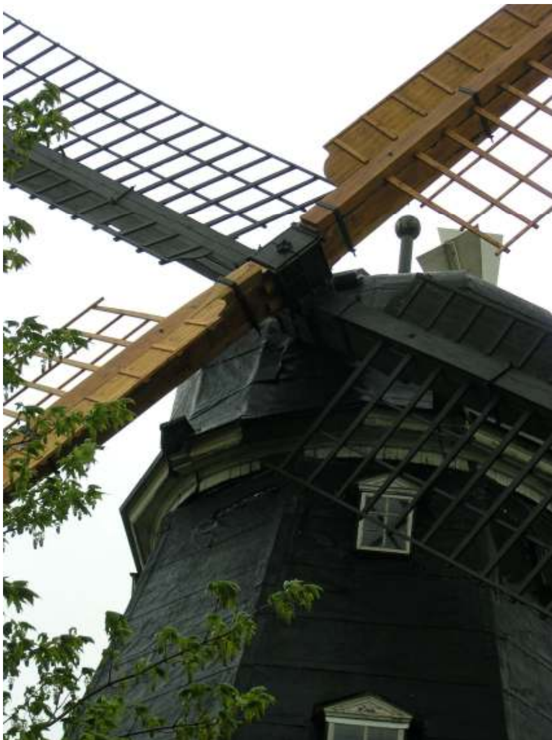
De nytillverkade klamrarna harmonierar, efter den förändrade ytbehandlingen, väl med de äldre klamrarna.
