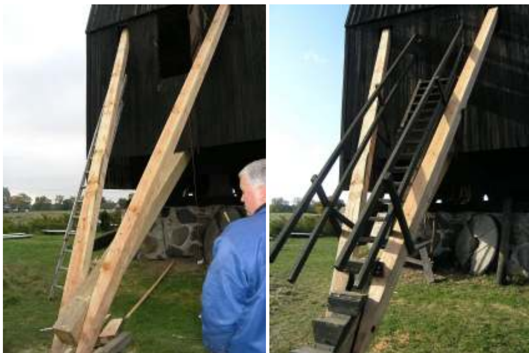
Montering av nytt svansträ och återmontering av trappsteg och räcken.
