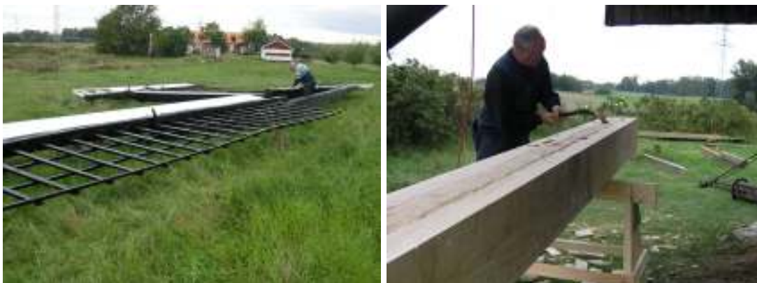
Smärre justering av vingarna t v samt tillyxning av nytt svansträ t h.
