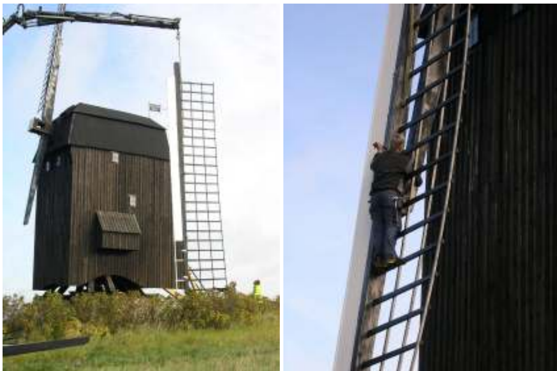
Återmontering av vingarna.
