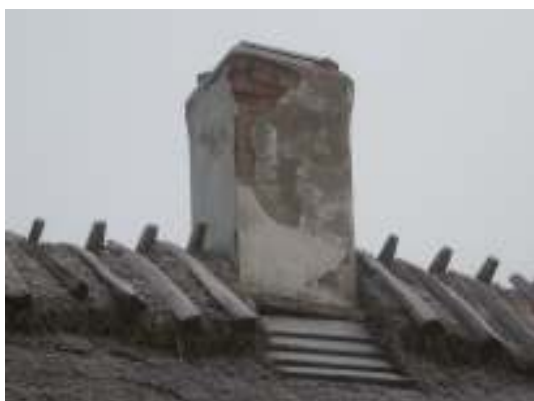
Skorstenen innan arbetet.
