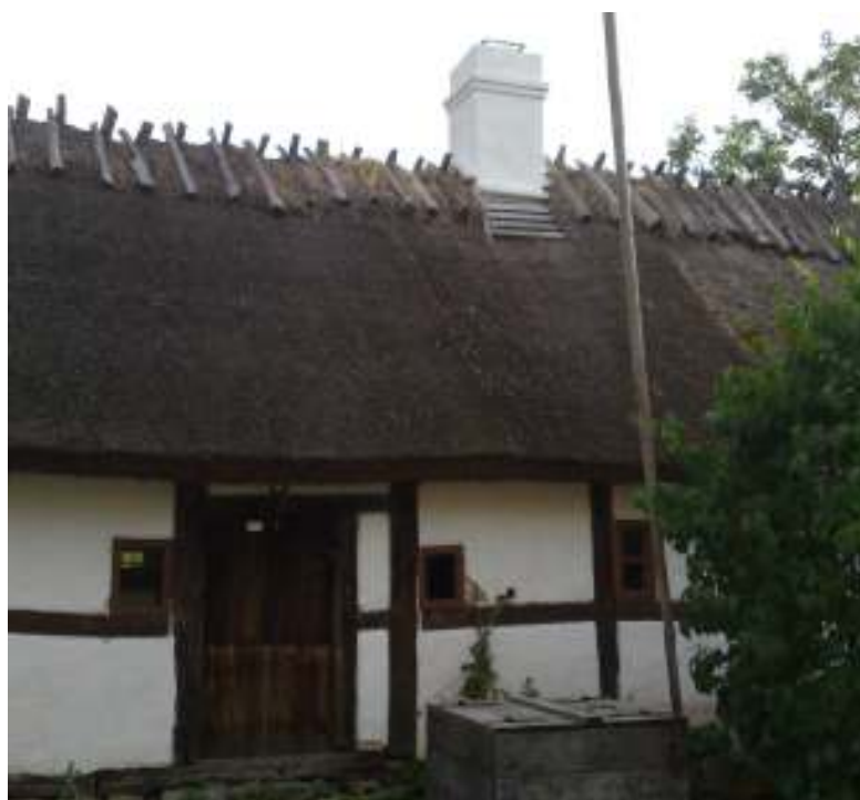
Skorstenen färdigputsad. Foto Henrik Nilsson, 2009.
