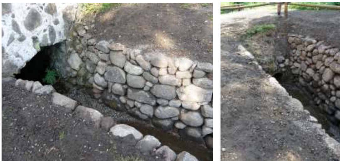
Bilderna visar muren utmed västra respektive östra sidan efter omläggning av stenarna.
