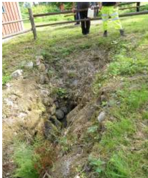
Vattenrännan innan arbetena påbörjades. Murarna buktar ut ungefär vid mitten av rännans sträckning.
