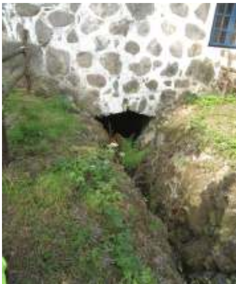
Vattenrännan innan arbetena påbörjades. Murarna buktar ut ungefär vid mitten av rännans sträckning.
