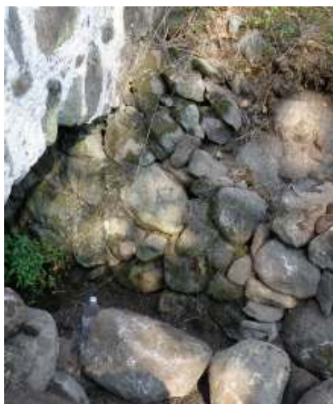
Vänstra bilden visar pågående omläggning av murarna och på den högra bilden syns det parti närmast byggnaden av den västra muren som lämnades utan åtgärd.
