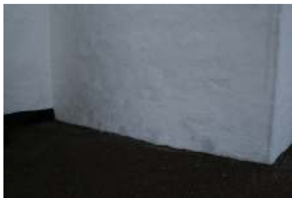
T.b.: Lagning av puts i norra tornmur. Lagningarna fortfarande synliga som något mörka fläckar vid fotograferingstillfället.
