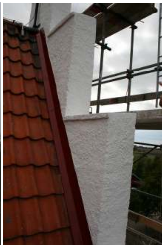
Nederst t.v.: Stränpelare med putslagningar fortfarande något mörka vid fotograferingstillfället.
