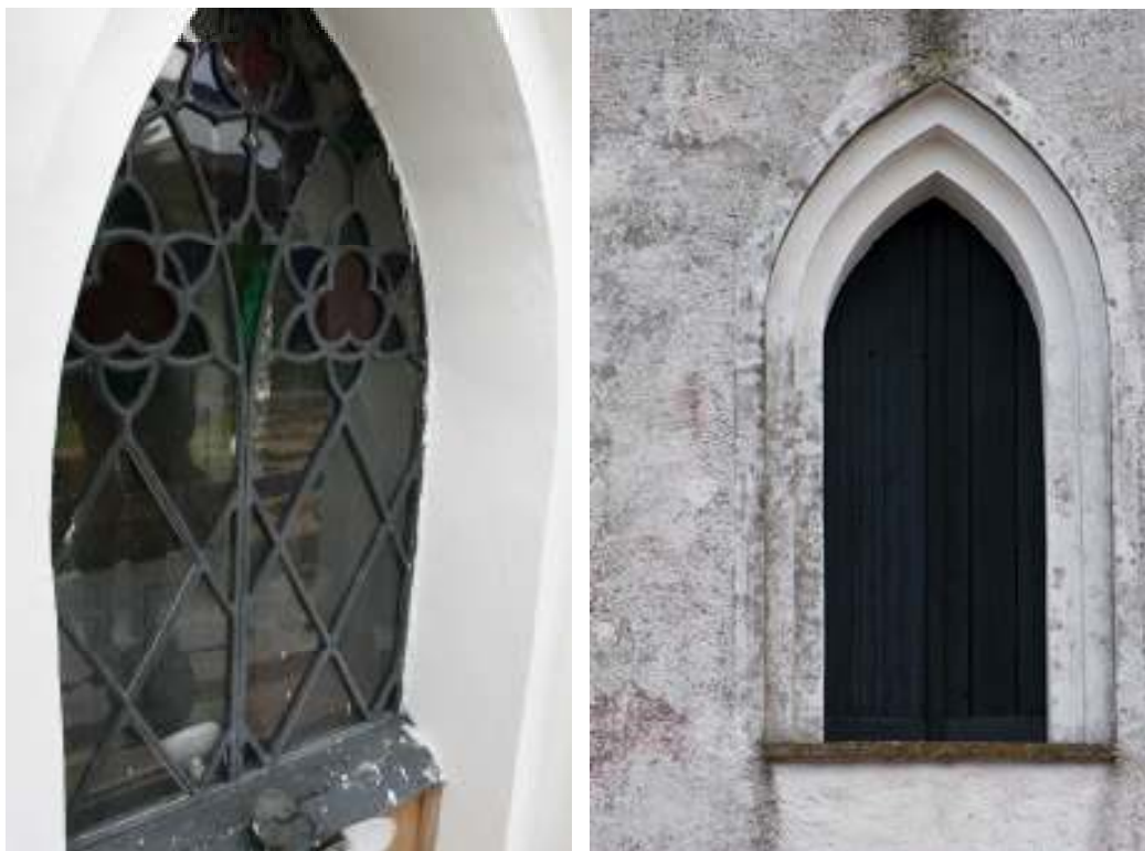
T.v.: Fönster innan renovering.
